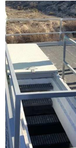
Sustitución de tapas pesadas por tapas correderas
