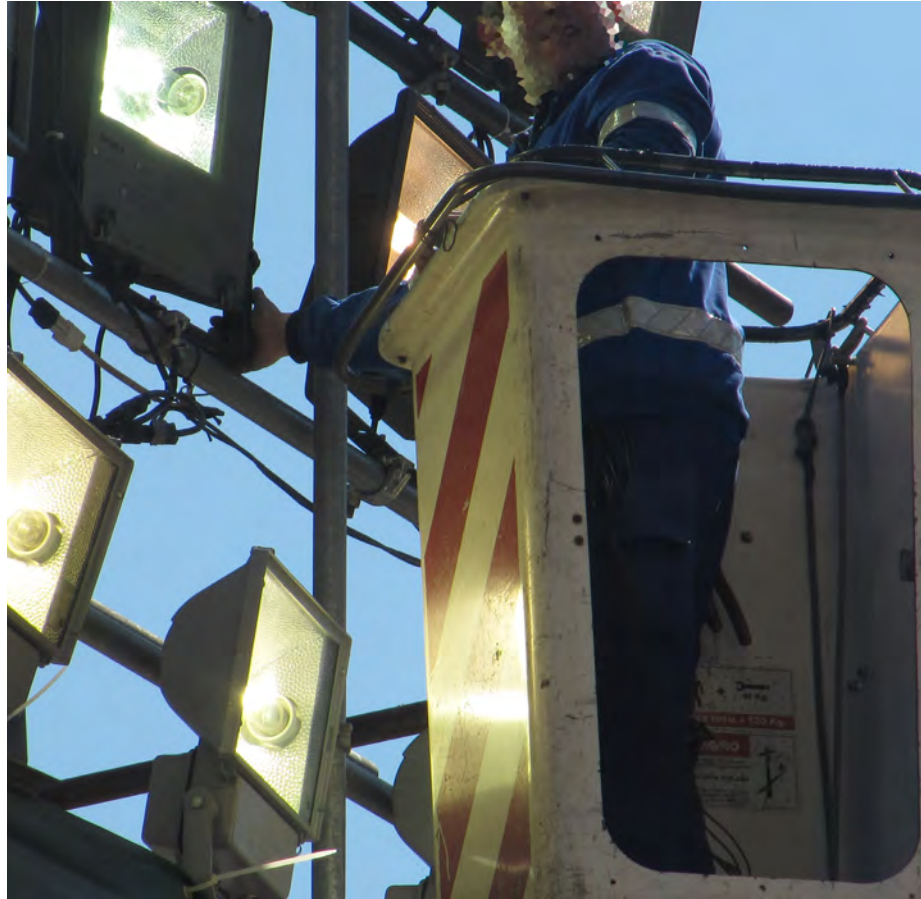
Montaje de instalación de alumbrado artificial. INVASSAT
