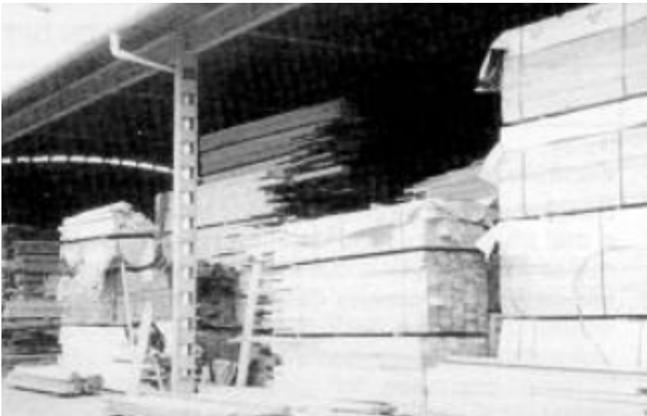
Apilado de paquetes de tablonos con calzos en sus bases y separación de paquetes. Fuente: NTP 220 . INSHT
