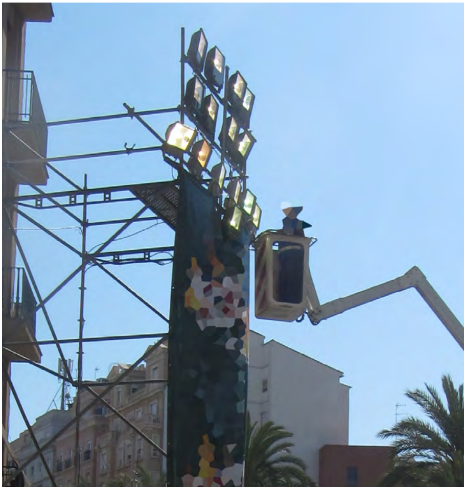
Montaje de instalación de alumbrado artificial. INVASSAT
