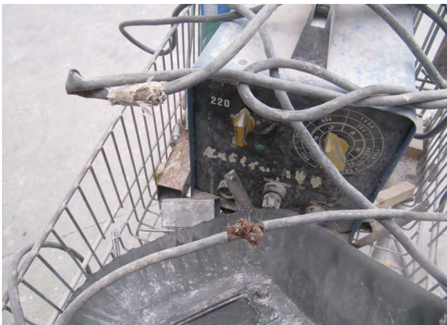
Los conductores defectuosos que han perdido su aislamiento también pueden convertirse en focos de ignición. INVASSAT
