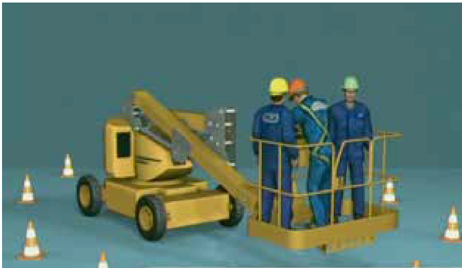
PEMP con exceso de personas. Fuente: INSHT. NTP 1039: Plataformas elevadoras móviles de personal (I): gestión preventiva para su uso seguro
