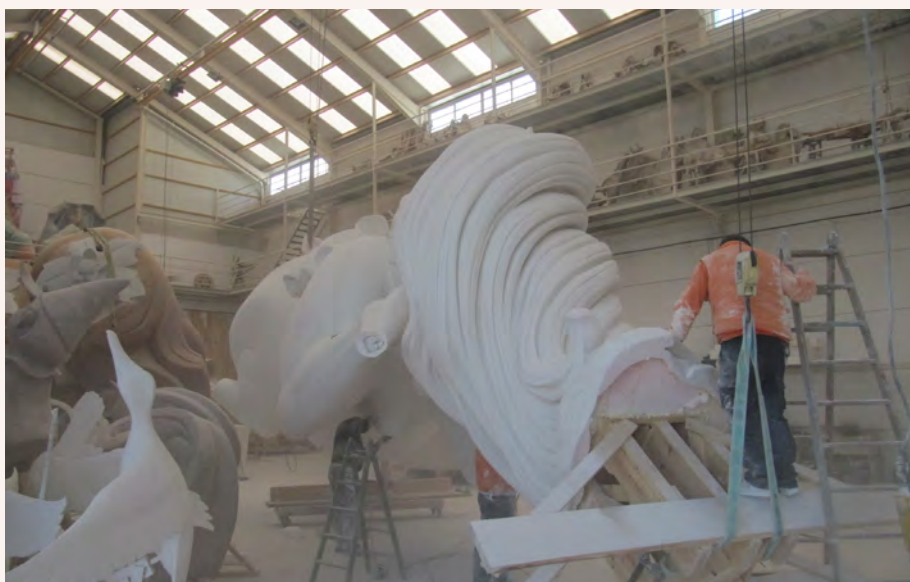
No deben realizarse trabajos sobre o debajo de una figura suspendida que no esté perfectamente calzada. INVASSAT
