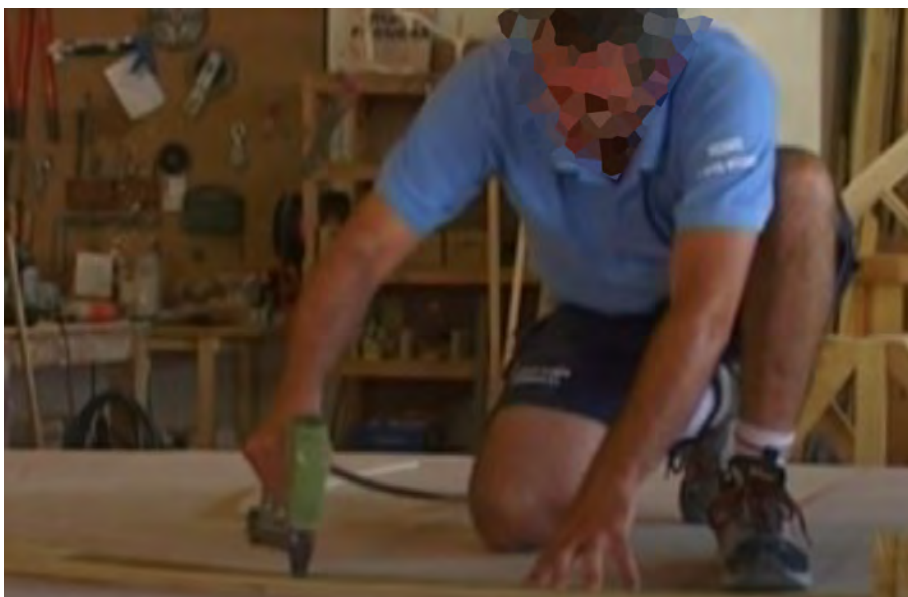
Tareas de poner clavos en estructura de madera.
