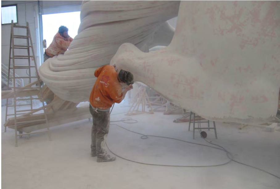
Trabajos de lijado. INVASSAT
