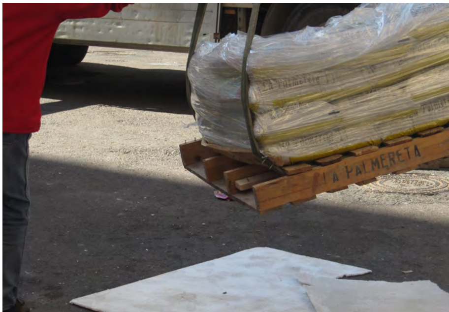
Los sacos terreros paletizados deben descargarse con carretilla elevadora como medio más adecuado y más seguro. INVASSAT
