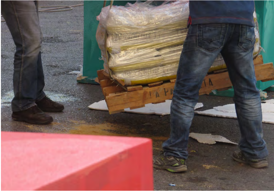
Los pies del trabajador se encuentran en la vertical de la carga. INVASSAT
