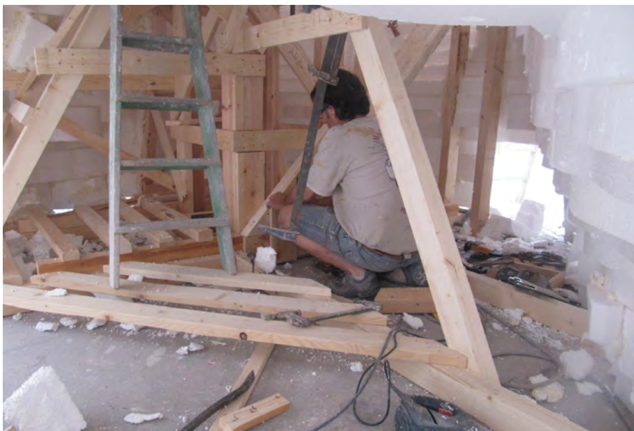
Trabajos de montaje de estructuras. INVASSAT
