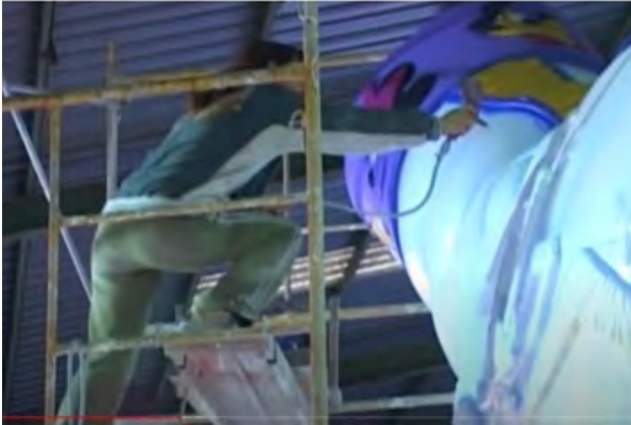
Trabajos de pintura. Fuente: https://www.youtube.com/watch?v=UUV-FAQSu7qU
