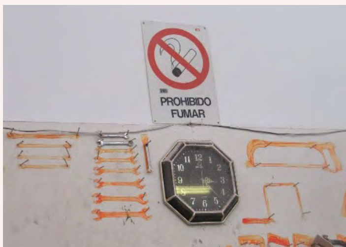
Señalización de prohibido fumar en la zona de carpintería de un taller. INVASSAT
