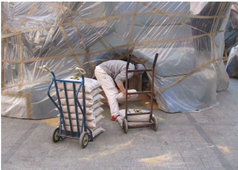
Colocación de sacos desde carretilla. INVASSAT
