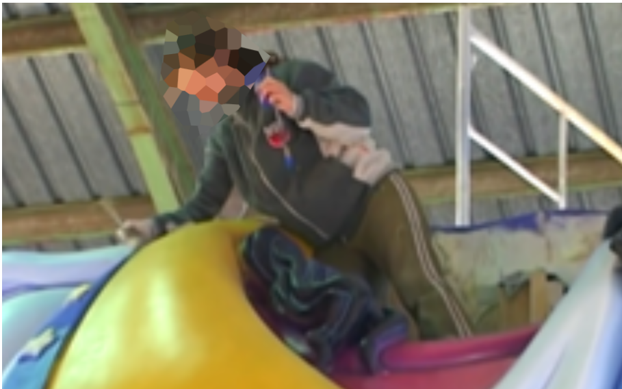
Trabajos de pintura. Fuente: https://www.youtube.com/watch?v=UUV-FAQSu7qU
