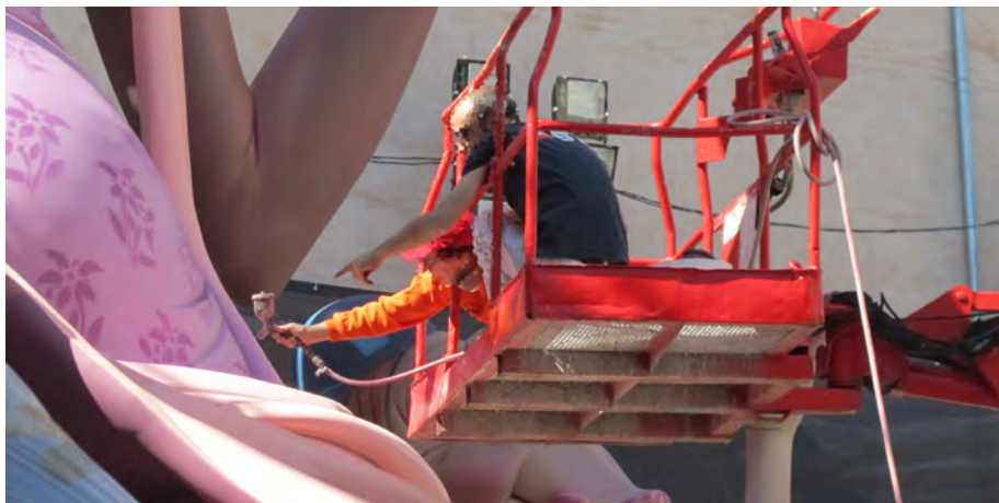
Remates de pintura realizados con pistola aerográfica desde PEMP INVASSAT
