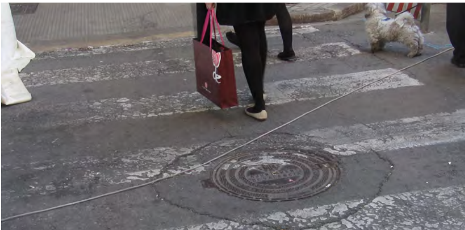
Tendido de canalización eléctrica sobre pasos de viandantes. INVASSAT
