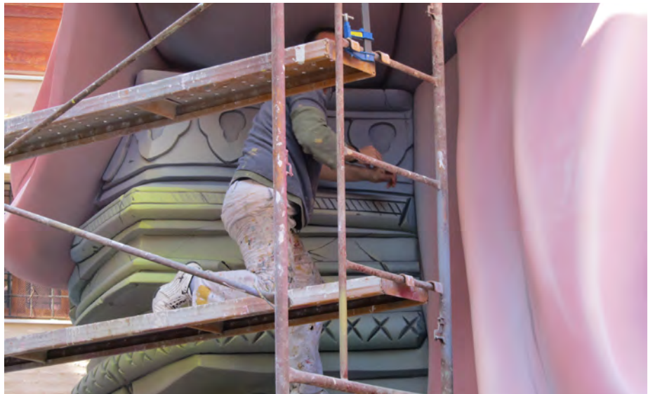
Andamio sin protección colectiva para poder acceder a un punto de operación. INVASSAT
