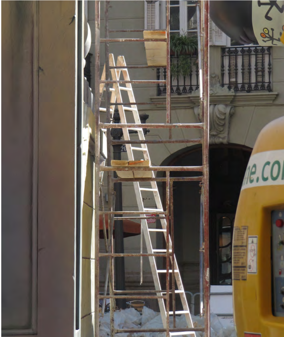
Utilización de andamio y escalera manual de tijera en el proceso de "plantà". INVASSAT
